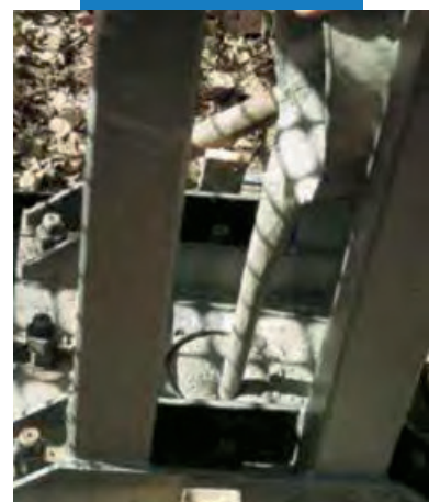
Анкерное крепление с помощью раствора Marerfill (Мапефил)
